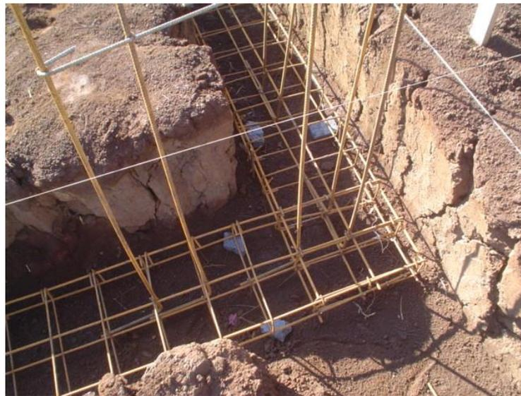
Imagen 1. Traslape de Armaduras y Colocación de Acero Vertical
