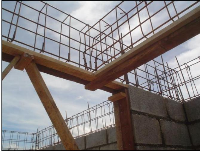
Imagen 5. Colocación y traslape de Armadura de Viga Corona.
