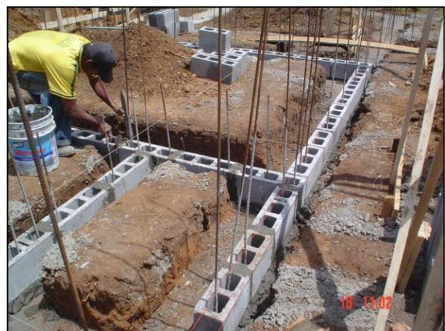
Imagen 4. Levantado de paredes y traslape de unidades.
