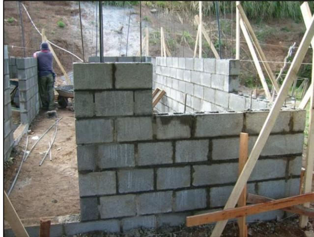
Imagen 2. Colocación y Relleno de Sisa Vertical
